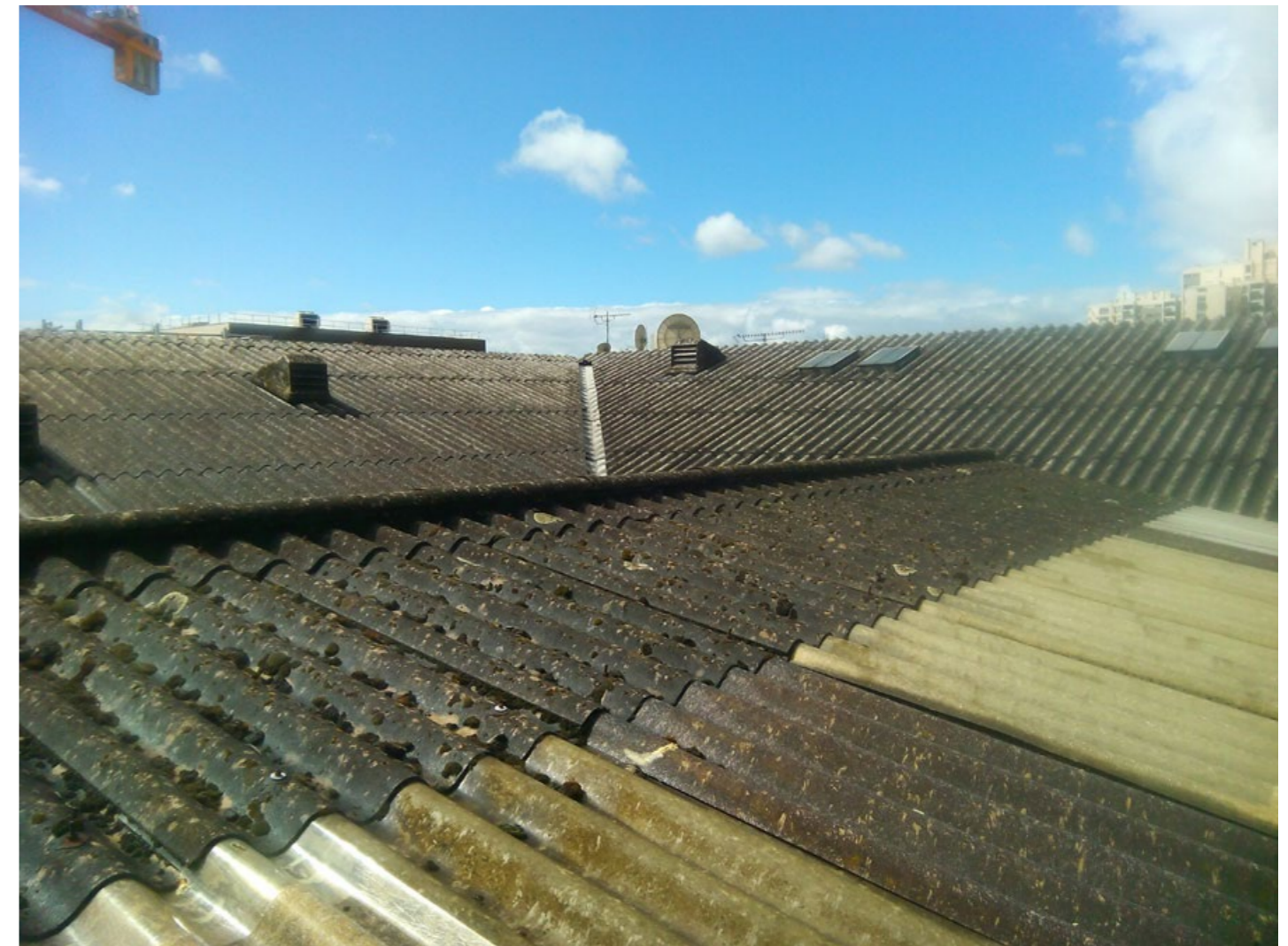
Toiture de l'atelier, été 2015
